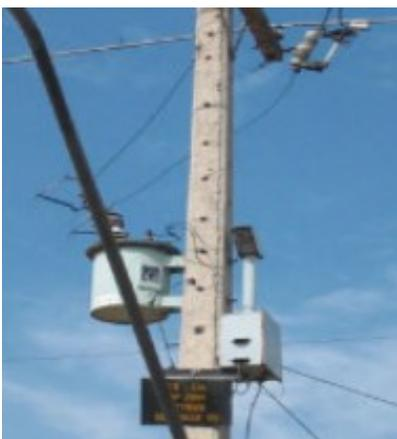
*Figura 5. Caja de Distribución Instalada en Poste del Transformador en el sistema DAE*
