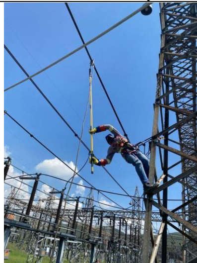
Instalación de puentes en 115kV.
