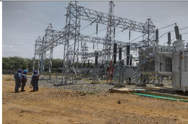
Instalación de los puentes en el transformador de potencia y en el interruptor y los transformadores de potencial
