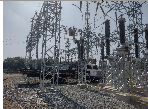
Instalación de extensión de la barra y puentes para el seccionador de barra
