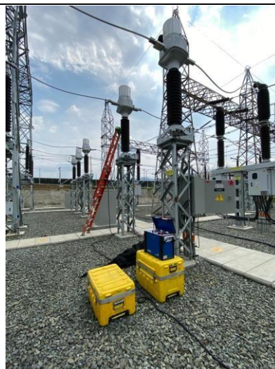
Prueba de estabilidad diferencial de barras en Termoyumbo.
