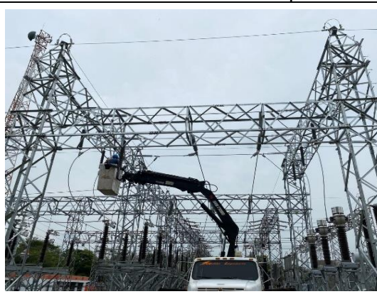
Instalación de extensión de la barra y puentes para el seccionador de barra
