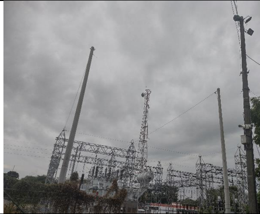
Instalación de apantallamiento sobre el transformador de potencia
