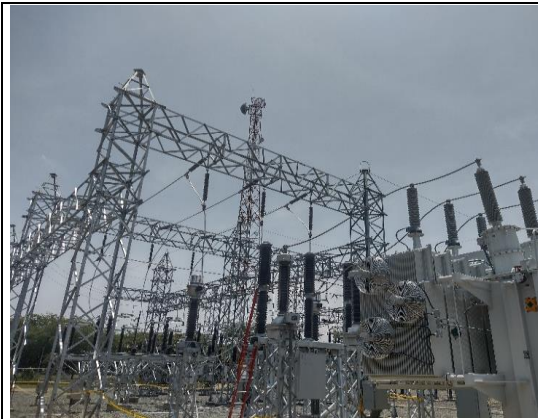
Instalación de los puentes en el transformador de potencia y en el interruptor y los transformadores de potencial
