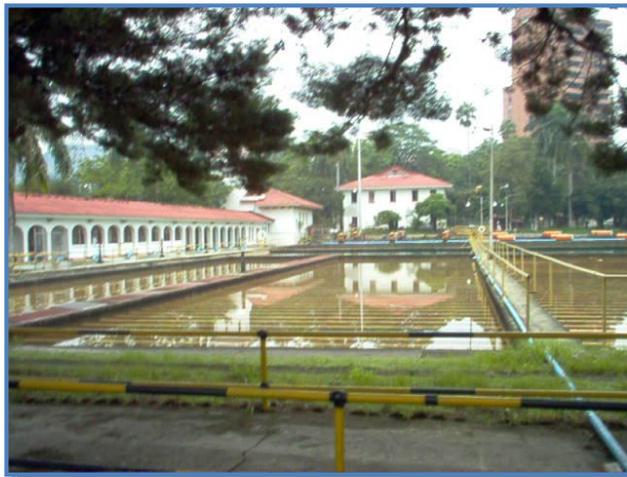
Para descontaminar las aguas residuales antes de verterlas al Río Cauca, EMCALI cuenta con la Planta de Tratamiento de Aguas Residuales PTAR Cañaveralejo, diseñada para tratar un caudal de 7.6 m<sup>3</sup>/s, con un tratamiento
