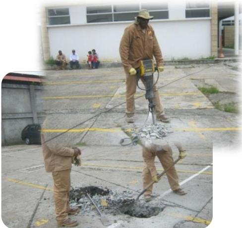
Perforación del concreto existente, para la elaboración de los ahoyados
