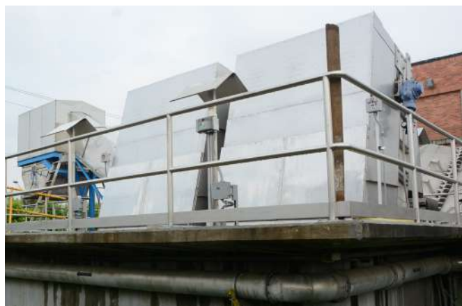
REPOSICIÓN BARANDAS REJAS GRUESAS
