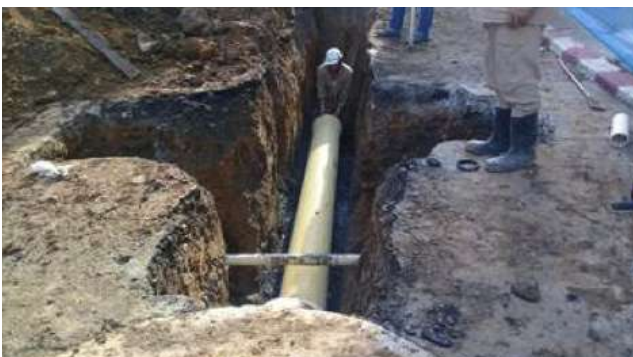
Instalación tubería de alcantarillado Avenida 4 (terron colorado) Cañaveralejo
