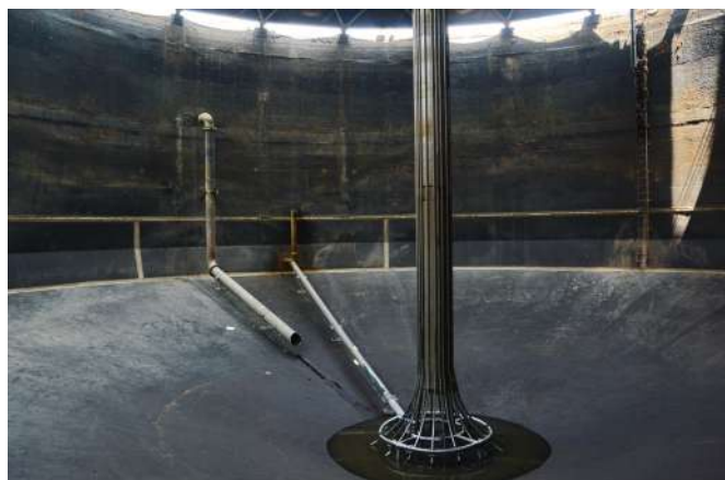
LIMPIEZA DIGESTOR A
