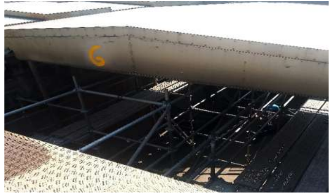
REFORZAMIENTO ESTRUCTURAL DESARENADORES
