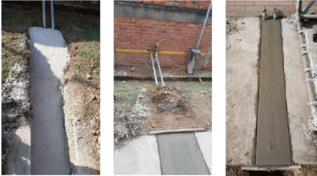
Instalación subterránea de tubería MTE de 1-1/2 pulgada para línea de cableado AC por debajo de tubería de gas
