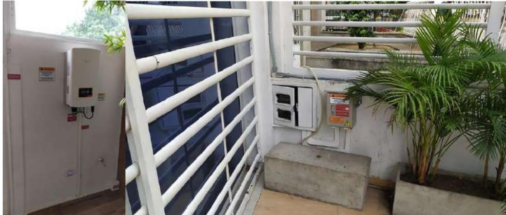
Inversor y caja de protecciones AC quedan totalmente conectados y a la vez el punto de inyección.
