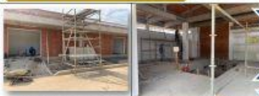
Ampliación Cables de Conexión (Módulos de panderas e inicio de instalación de bobinas oleo).
