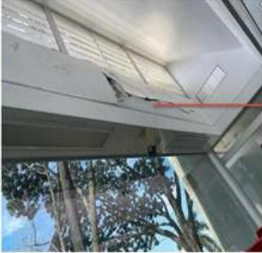
Humedad a nivel de paredes, provocando que se descascare fachada y los restos del material caigan sobre los equipo como se observa en las imágenes, aparte de representar una condición totalmente peligrosa para el personal que se encuentra debajo realizando labores.
