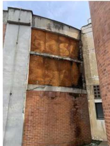
Las paredes y mampostería de los digestores están en muy mal estado, requiere una intervención urgente
