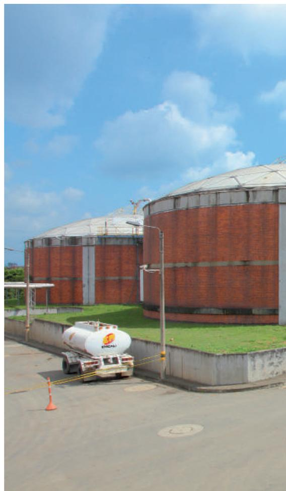
El tratamiento primario avanzado (TPA), implementado ha permitido mejorar la calidad del efluente de la PTAR-C y reducir la carga orgánica en términos de DBO<sub>5</sub> y SST, vertida al río Cauca. Dicho tratamiento consiste en el mejoramiento del proceso de sedimentación primaria, mediante la aplicación de coagulantes químicos que permiten la floculación de sólidos disueltos y de materiales coloidales en "flocs", los cuales están en capacidad de ser separados en el sedimentador primario.
