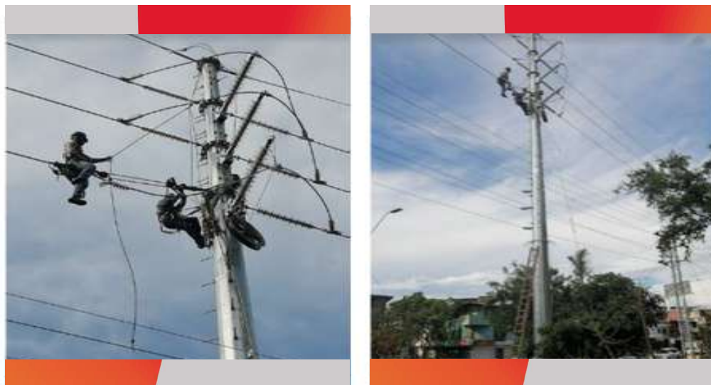
Proceso de construcción de puentes en estructura de retención
