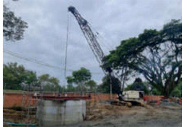
**Figura 24. Construcción de un sistema de captación del Río Cauca tipo filtración en lecho de río en el municipio de Santiago de Cali**
